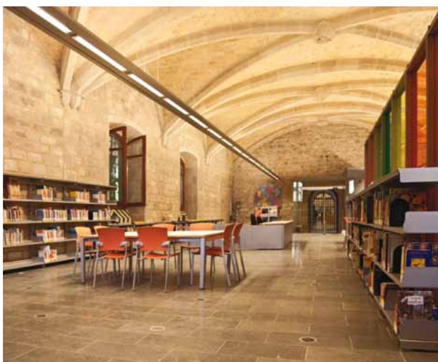
BIBLIOTECA SAN PAU, BARCELONA. ADEMÁS DEL STC INCORPORA INSTALACIONES DE CLIMA RADIANTE Y VENTILACIÓN.
