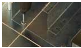
3. FIJACIÓN ENTRE NUDOS Y CANALES.
