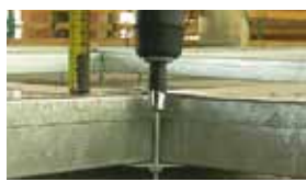
5. NIVELACIÓN DEL SISTEMA COMPLETO DESDE LOS NUDOS.
