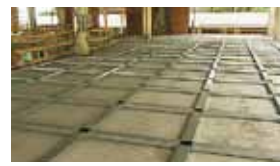
4. DISTRIBUCIÓN DE LA MALLA DE CANALES STC.
