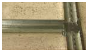
2. INSTALACIÓN DE CANALES TÉCNICOS.
